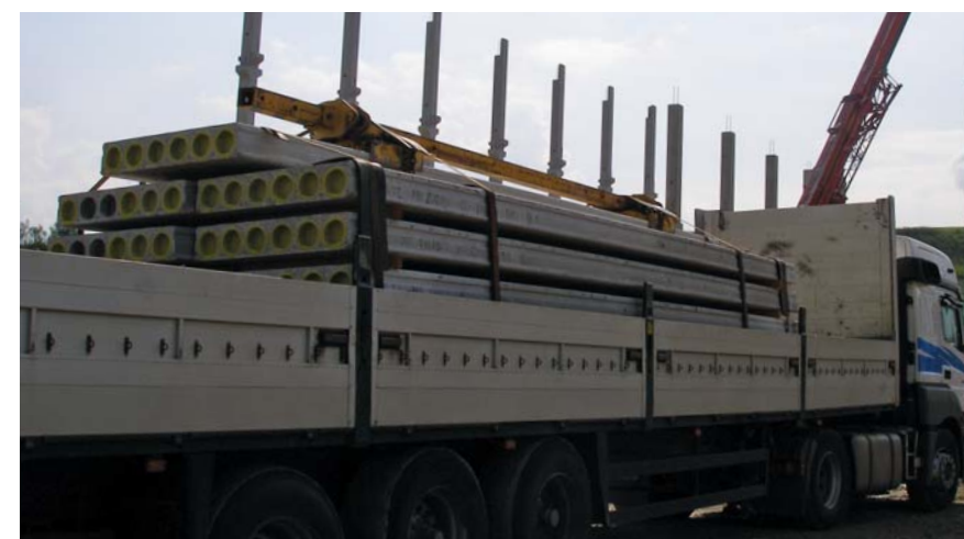
Obr. 22: Uložení panelů SPIROLL na dopravní prostředek
