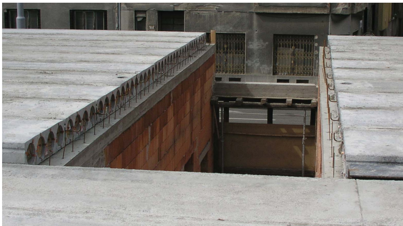
Obr. 3: Stropní konstrukce se zalitými spárami
