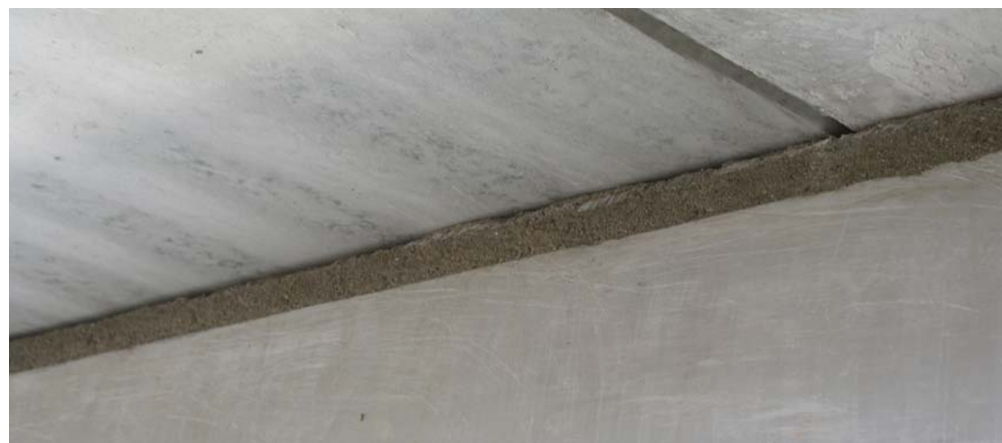
Obr. 15: Uložení panelů SPIROLL na železobetonovém průvlaku
