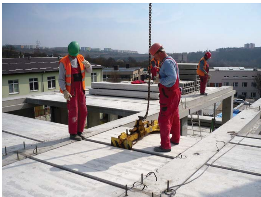
Obr. 19 a 20: Montážní pomůcky – na fotografiích jsou zachyceny montážní samosvorné kleště, které se používají při manipulaci s panelem.
